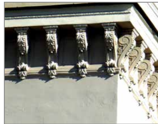
Консоли, поддерживающие карниз сценической части.
