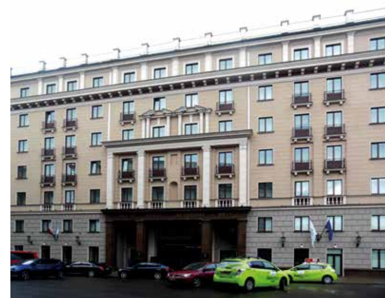
Рига, 2018, гостиница «Рига» после капитального ремонта и перестройки оконных проемов, вид со стороны трапецевидной площади.
