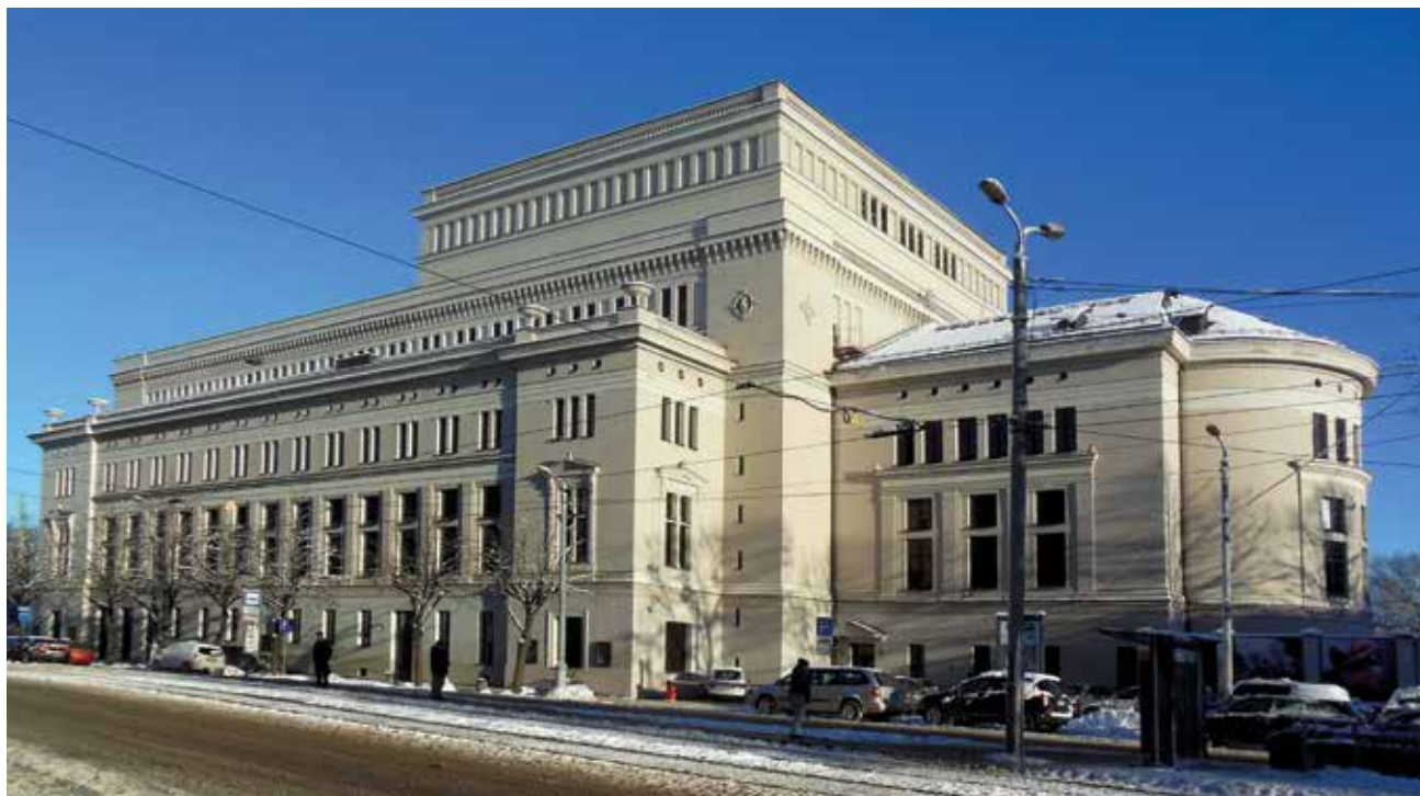
Общий вид Рижской Оперы с пристройкой-апсидой, архитектура фасадов которой развивает идеи «музыкальной шкатулки» Л. Бонштедта.
