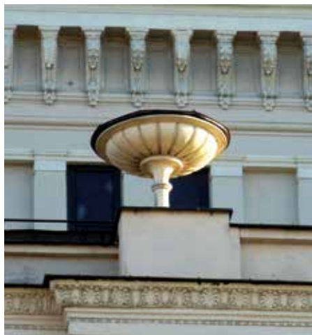
Вечно крутящаяся ваза, установленная на углах ризалита.
